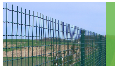
Du Fortiplast® pour la protection d'une autoroute
